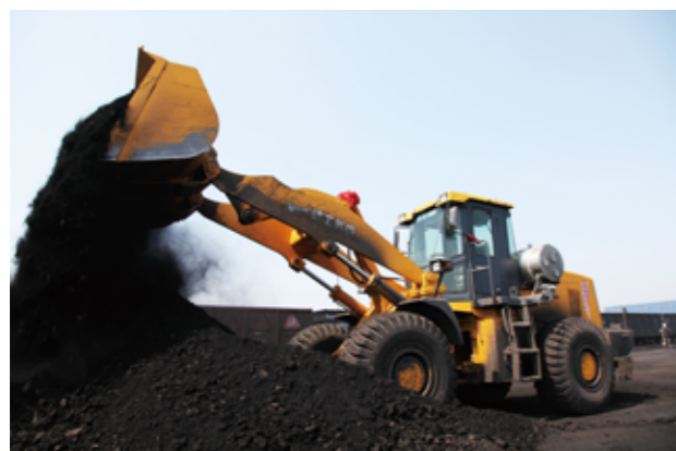
• 徐工LW600K-LNG装载机港口施工
