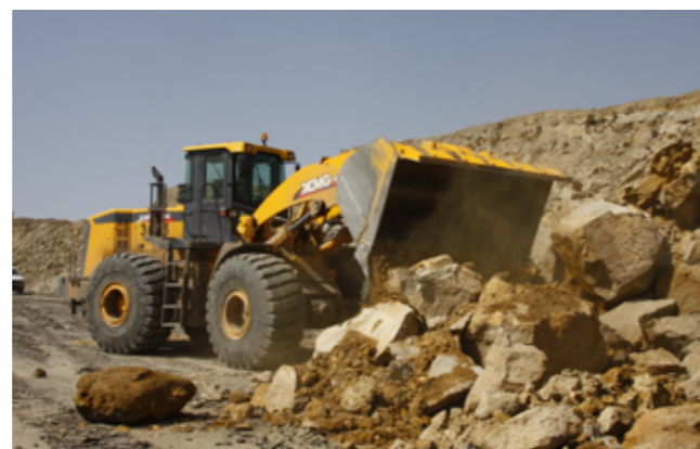
• 徐工LW800K装载机恶劣工况施工
