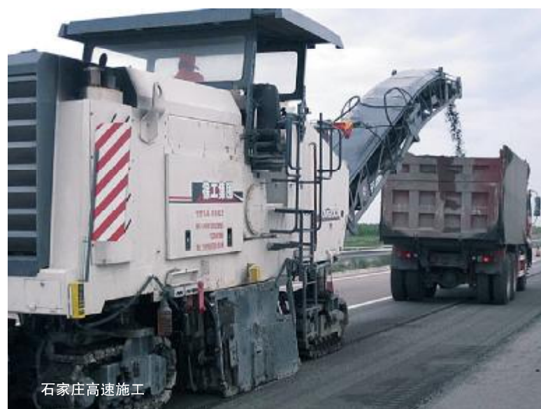
昆山经济开发区XM200铣刨机施工
