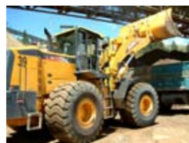
◆ 狭窄区域内施工
